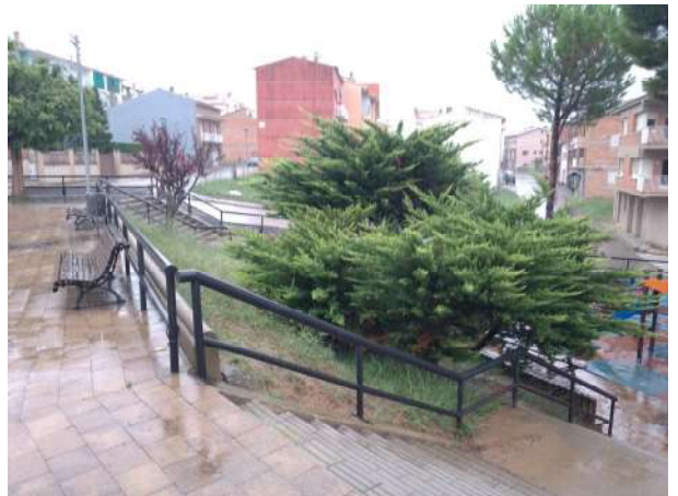
Talús entre la zona infantil i la plataforma de les pistes esportives
