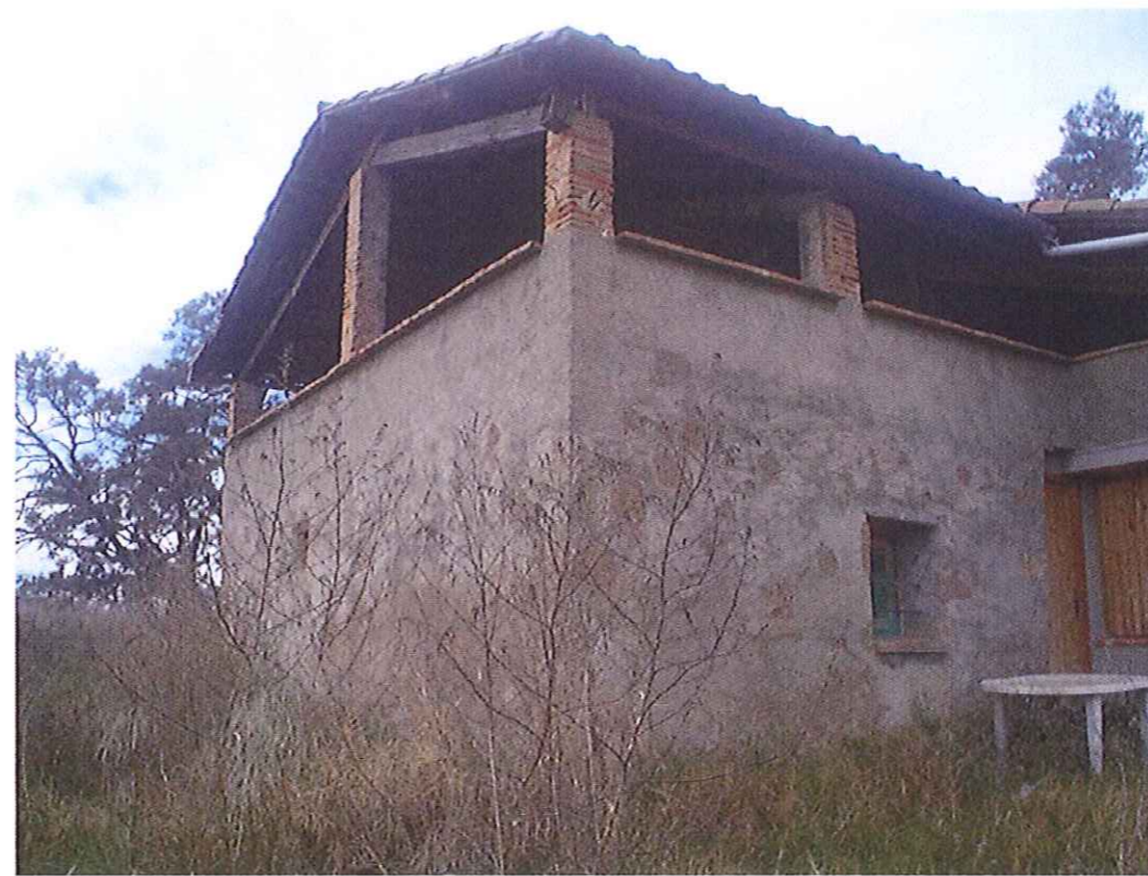
FOTO 6 Masia La Serreta. Façana sud
