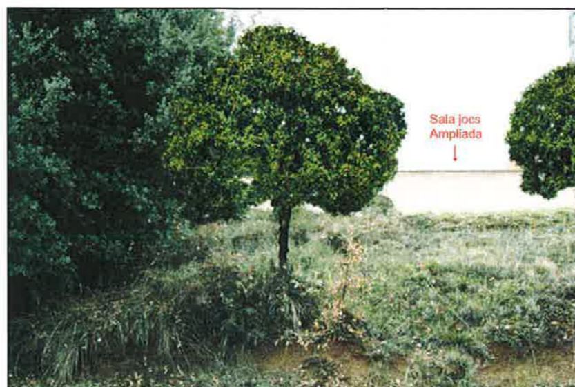
Vista Est dels edificis auxiliars i sala de jocs i activitats
