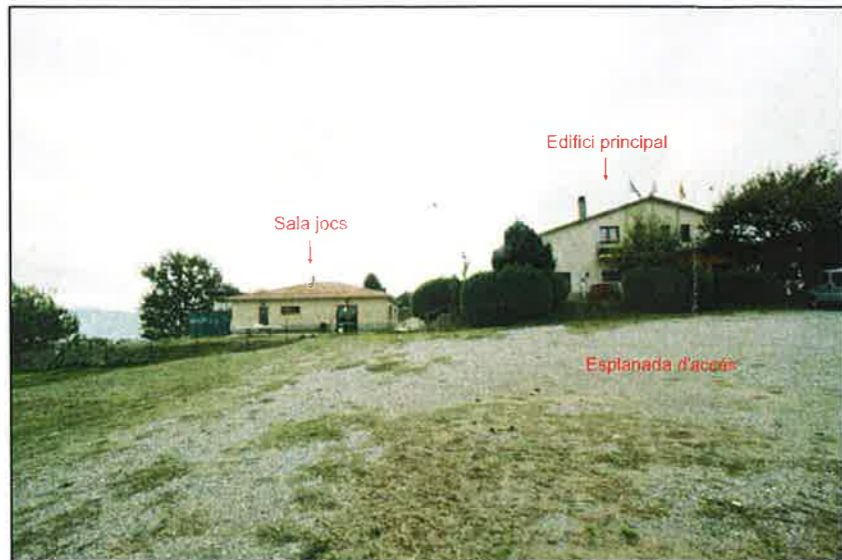
Foto 8 Vista Nord de l'edifici principal i de la sal de jocs ( estat actual)
