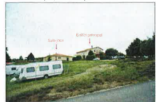
Vista Est dels edificis auxiliars i sala de jocs i activitats
