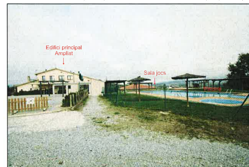
Vista Sud de l'edifici principal i instal.lacions annexes (ampliació)
