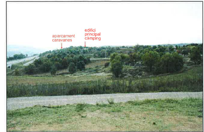
Foto 3 Vista de l'edifici principal Nord des del Camí a St. Marc
