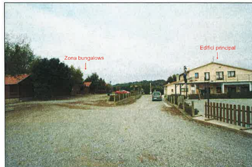
Foto 14 Vista Sud dels edificis auxiliars i del principal
