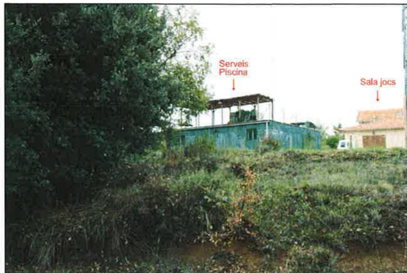
Foto 11 Vista Est dels edificis auxiliars i sala de jocs i activitats
