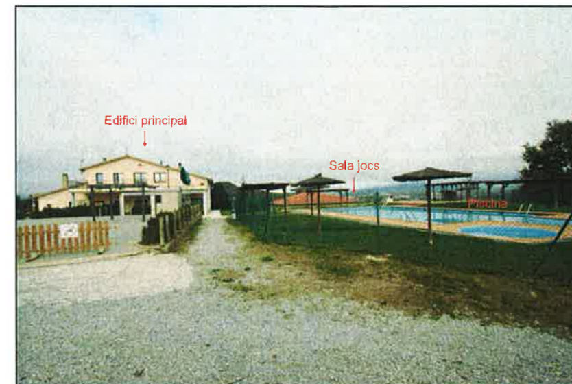
Foto 13 Vista Sud de l'edifici principal i instal.lacions annexes (estat actual)
